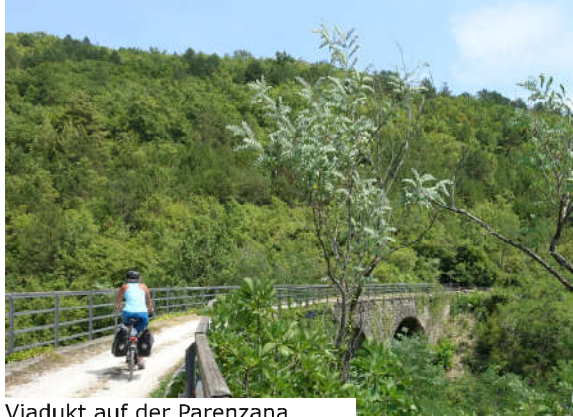
Viadukt auf der Parenzana
