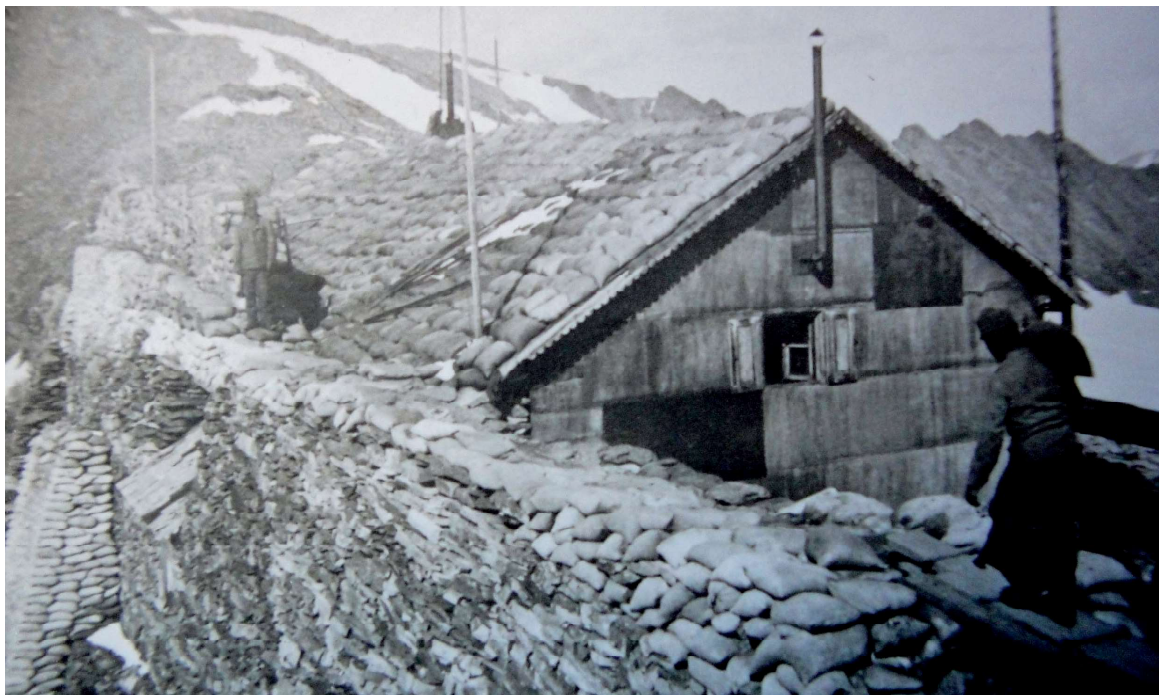
Abb. 4 zu Seite 70: Die Hallesche Hütte im Ersten Weltkrieg Sandsackmauer gegen italienischen Beschuss Foto: Haringer
