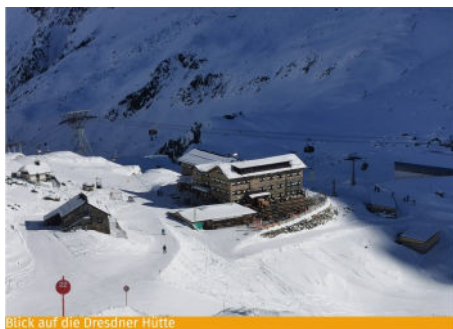
Blick auf die Dresdner Hütte
